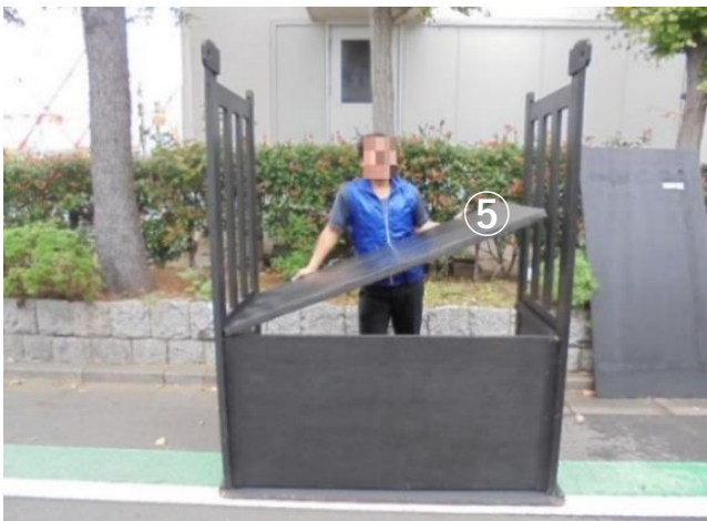
(7)天板⑤を設置
