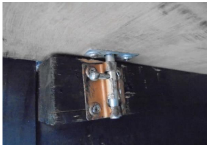
(9)天板下の金具を取付けます (左右二か所)
