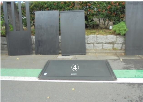
(2)底板④を設置 (赤のパンチカーペットを下にします)
