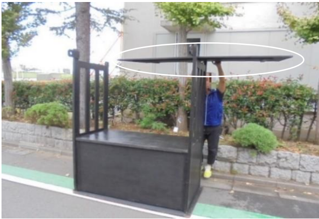
(10) 天上板③を設置
